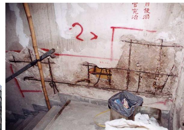
圖2.6.12 樓宇失修引致鋼筋外露
